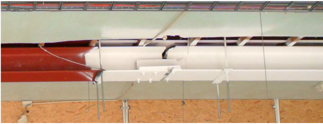
Verbinding onderslag dak (hoog)
