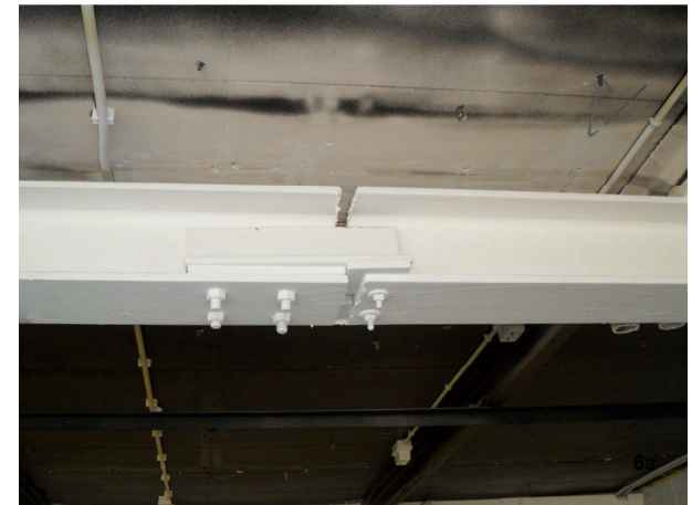
Verbinding onderslag dak (laag)
